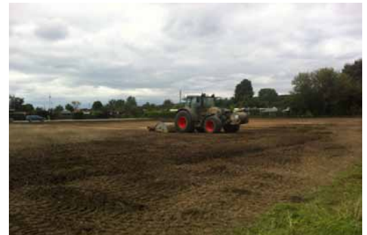
Errichtung des 3. Sportplatzes 2016
