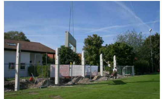
Bau der Tribüne 2014
